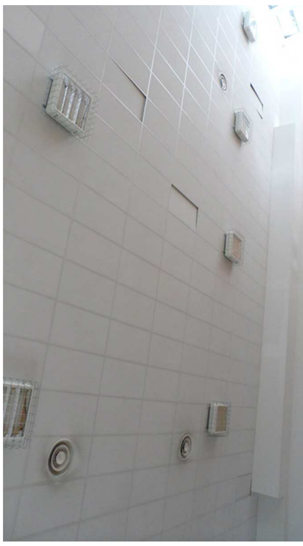
Spostamento dei pannelli di controsoffitto
