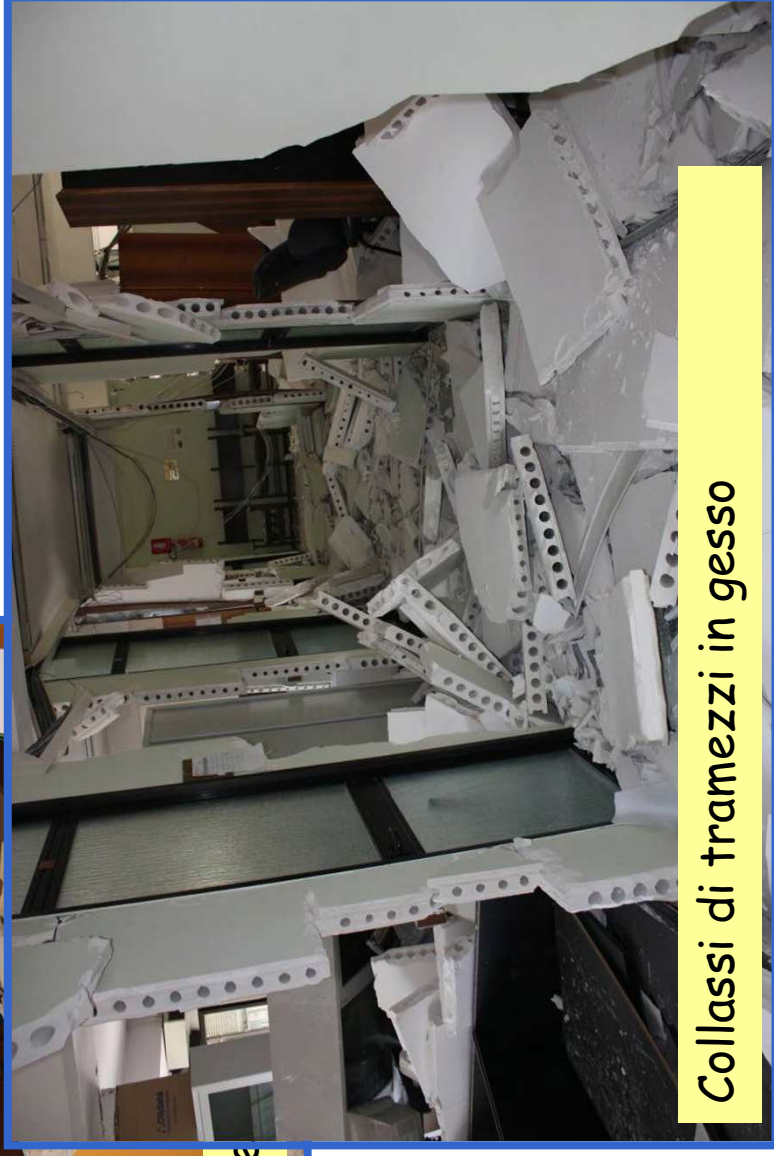
Collassi di tramezzi in laterizio
