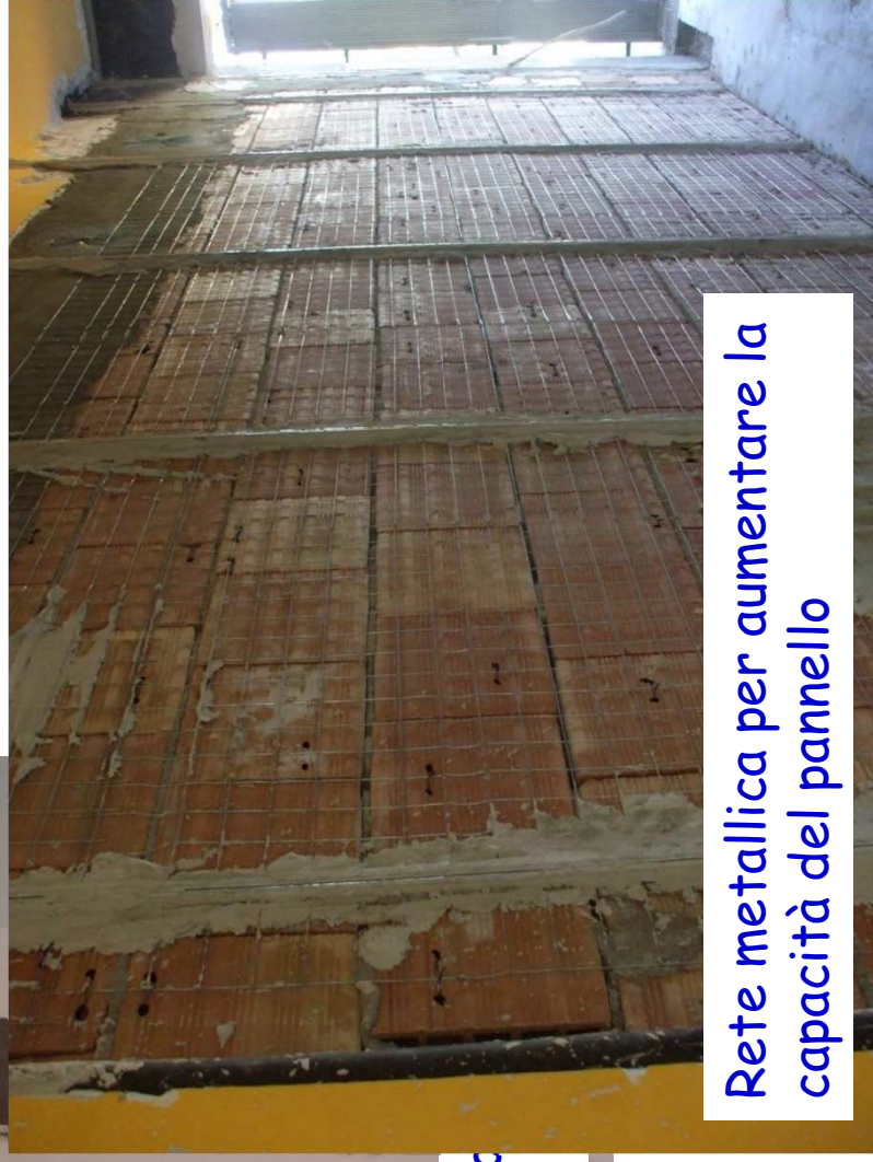
miglioramento della connessione pannello-reticolo strutturale
